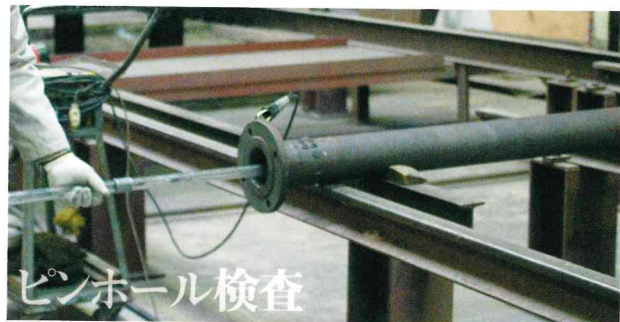
03-2 管に1,000ボルトの高電圧をかけ、ピンホールの有無を調べます。
